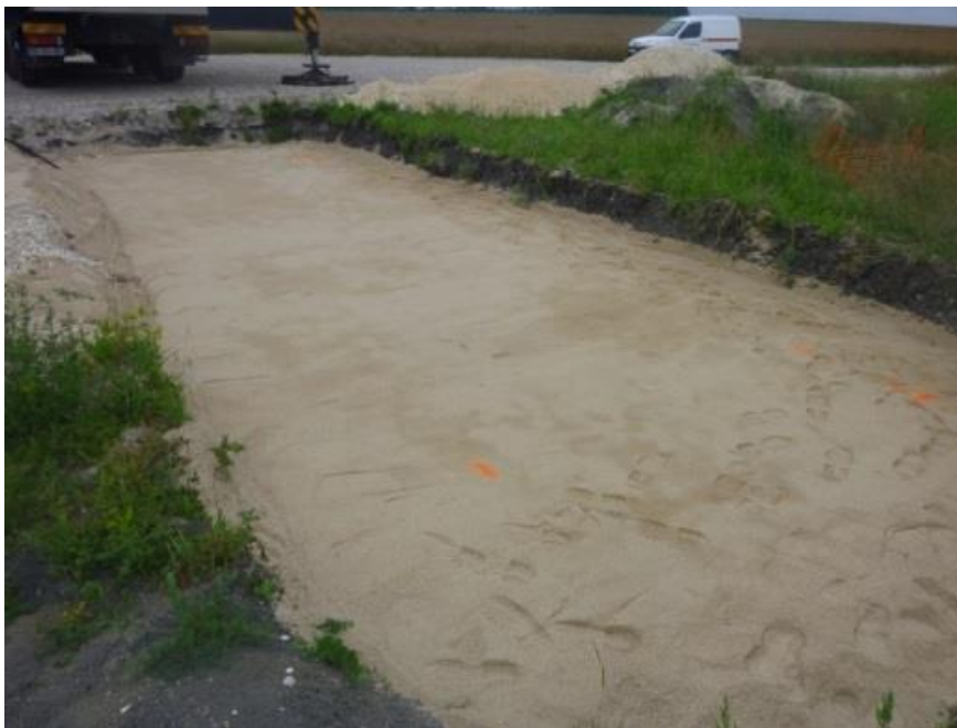
Exemple de fond de fouille pour poste de livraison éolien.
