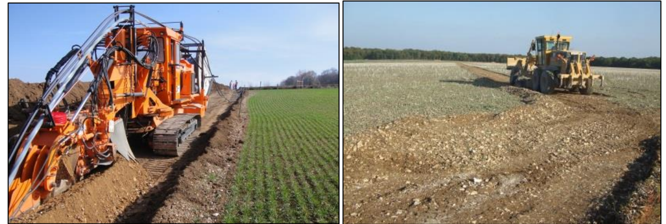
Décapage pour câblage
