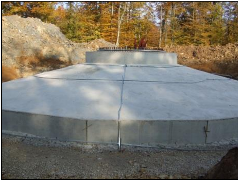
Massif d'éolienne avec ceinture équipotentielle pour MALT
