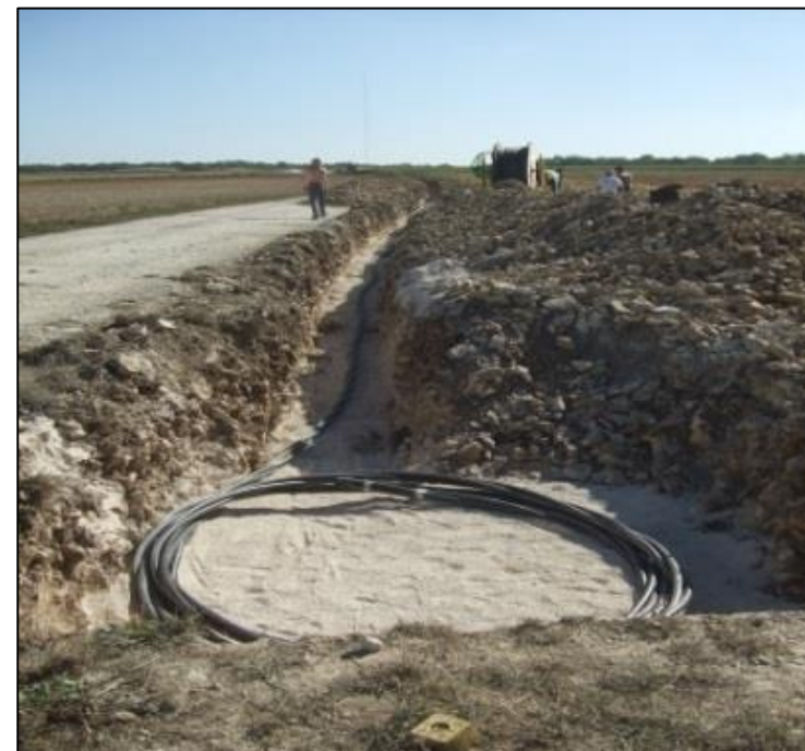
Pose de réseaux HTA
